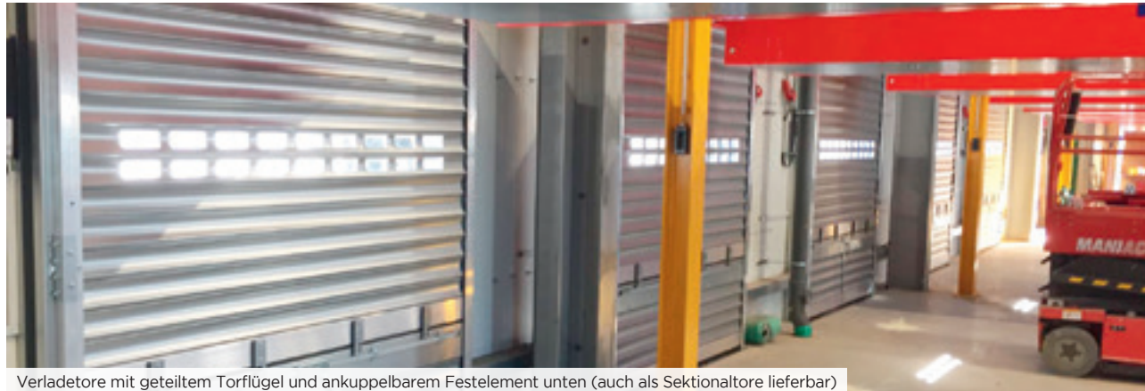
Verladedore mit geteiltem Torflügel und ankuppelbarem Festelement unten (auch als Sektionaltore lieferbar)
