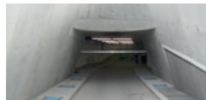
Rollgittertor in einer Zufahrt mit schrägen Wänden und gewölbter Decke eingebaut
