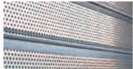
Lamellen (nur gelocht als M10p) 25 % Lüftung
