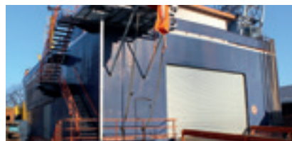
Rolltor als Außenabschluss auf einem Seeschiff montiert
