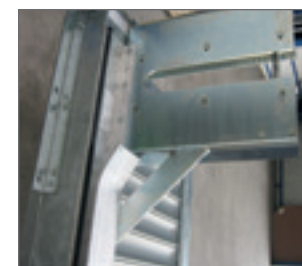
Tor fertig auf Unterkonstruktion montiert
