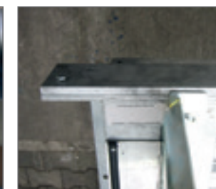
Distanzplatte oben, zur einfacheren Befestigung
