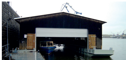
Rolltor in schwimmender Bootsgarage, mit Fernsteuerung
