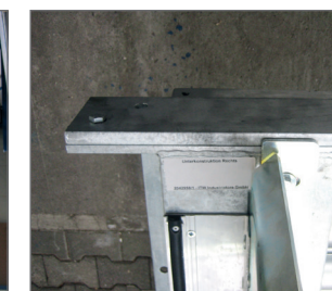
Distanzplatte oben, zur einfacheren Befestigung
