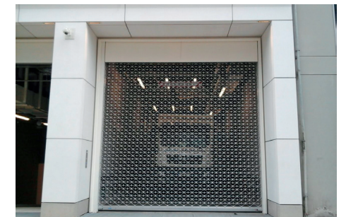
MRAT trend mit Unterkonstruktion und Blechverkleidung
