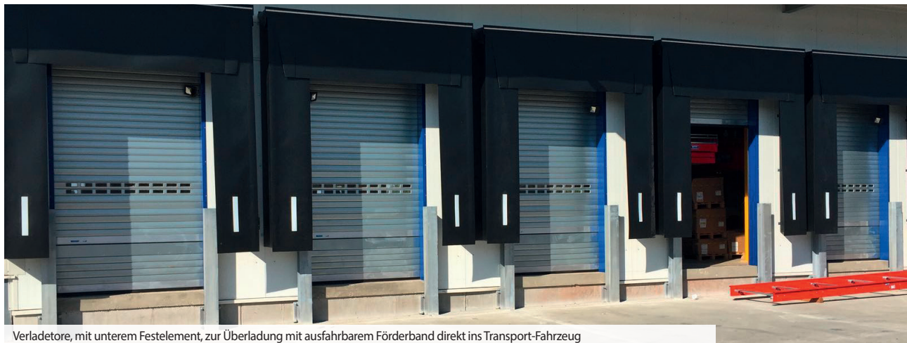
Verladedore, mit unterem Festelement, zur Überladung mit ausfahrbarem Förderband direkt ins Transport-Fahrzeug
