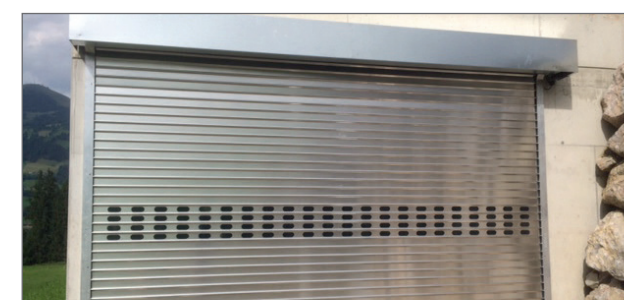
Rolltor als Außenroller mit Blendkasten
