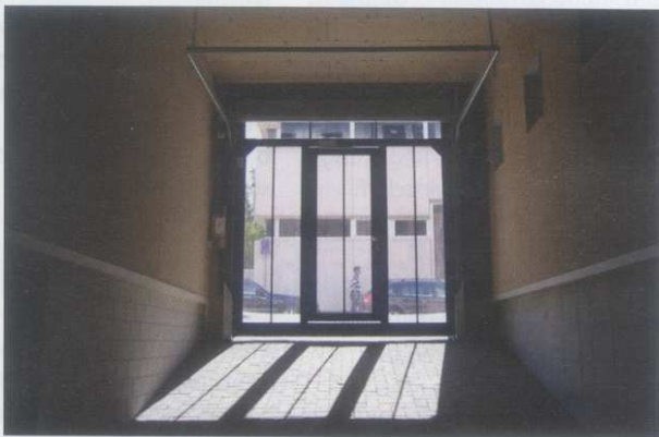
MKTG (Innenansicht) mit integrierter Schlupftür und Lochblechfüllung Bild: Meißner
